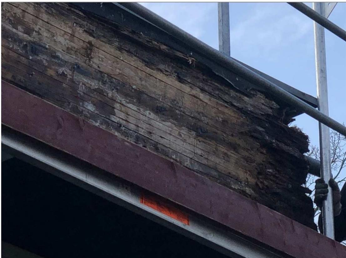
Die Unterkonstruktion ist aufgrund der Durchfeuchtung zum Teil nicht mehr vorhanden. Der Schaden war im Vorfeld nicht erkennbar, da die Faserzementplatten keine optische Änderung durch das anstehende Wasser erfahren haben.
